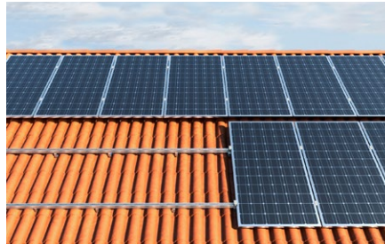
Copertura inclinata con rivestimento in tegole.
