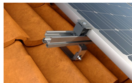
Copertura inclinata con rivestimento in tegole.
