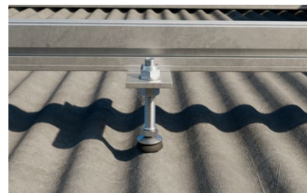
Copertura inclinata con rivestimento in lastre ondulate di laterocemento.
