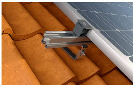
Copertura inclinata con rivestimento in tegole.
