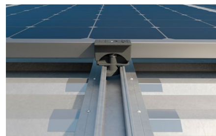
Copertura con rivestimento in lamiera grecata.
