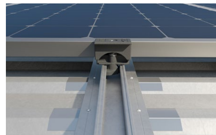
Copertura con rivestimento in lamiera grecata.
