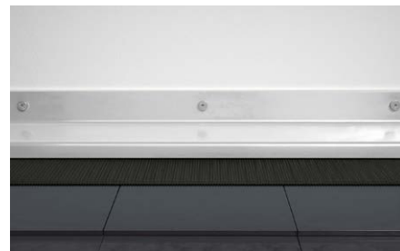
Fissaggio di scossaline in lamiera.
