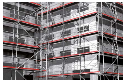
Ponteggio per facciata
