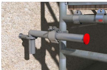
Fissaggio al ponteggio
