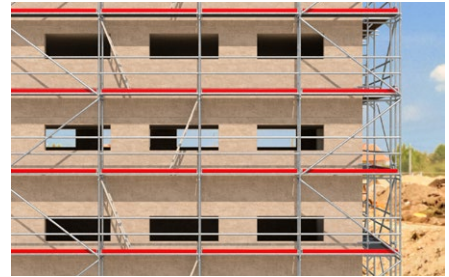
Ponteggio per facciata.
