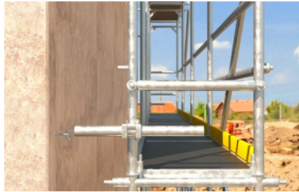
Fissaggio al ponteggio.
