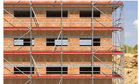
Ponteggi di facciata.
