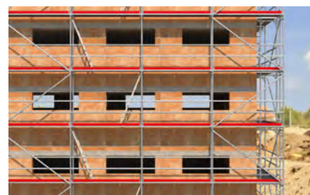
Ponteggio per facciata.
