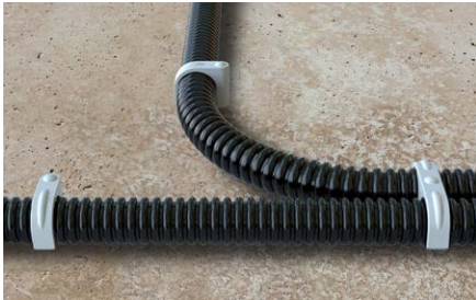
Fissaggio di corrugati.
