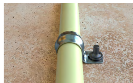
Fissaggio di tubi.
