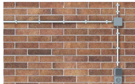
Fissaggio di tubi in PVC.
