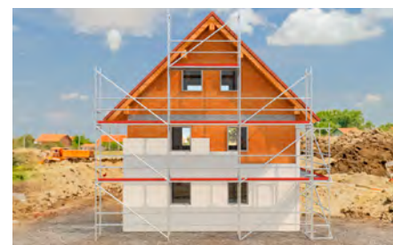
Fissaggio di pannelli di isolamento a cappotto.
