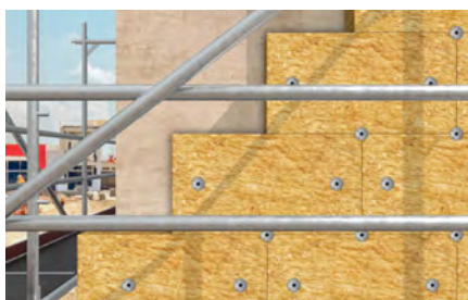
Fissaggio di pannelli resistenti a compressione.
