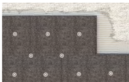
Fissaggio di pannelli isolanti.
